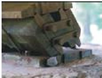
Разместване на лагерните части, причинено от деформации на опорите
