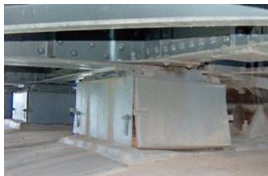
Защитен кожух на подвижен лагер
