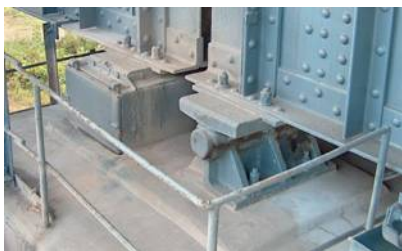
Защитен кожух на подвижен лагер
