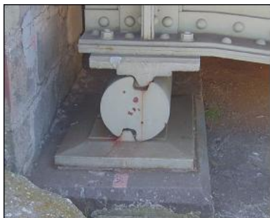
Разместване на лагерните части, причинено от деформации на опорите
