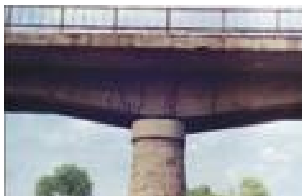
Разместване на лагерните части, причинено от деформации на опорите
